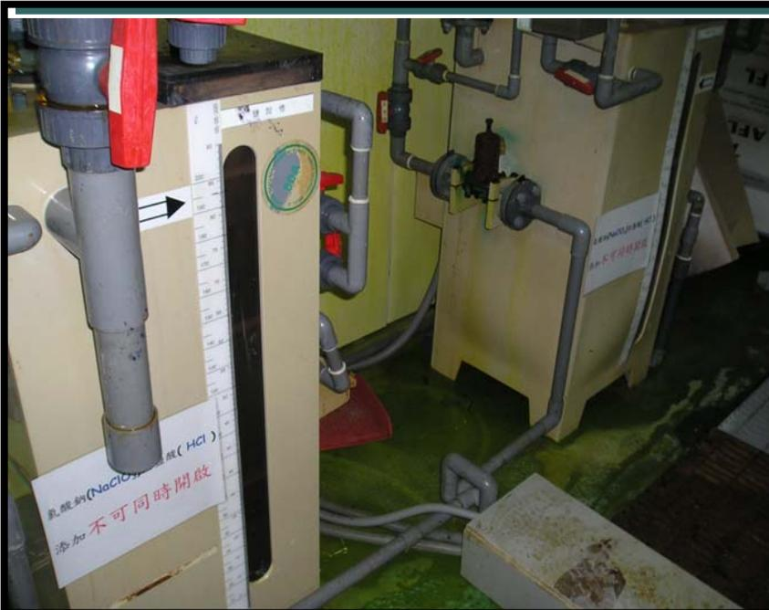
肇災當時相片：32%鹽酸與35%氯酸鈉溶液之容量緩衝槽設置處，鹽酸及氯酸鈉之緩衝槽未適當隔離，因同時輸入鹽酸及氯酸鈉溶液，兩溶液溢流至地面混合反應產生氯氣，塗裝綠色耐蝕環氧樹脂之水泥地面已有些許腐蝕，地上尚有因地面因以水沖洗後之潮溼情形，緩衝槽前方鐵柵溝蓋下方為排水溝，地面之液體已由排水溝排除。
