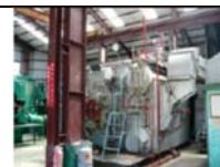
備註：水管式鍋爐
